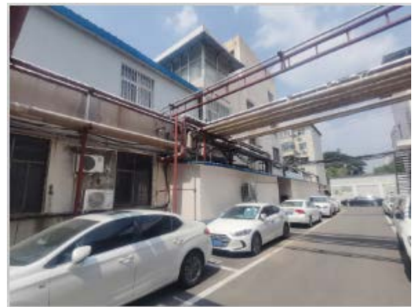
3 号病房楼东侧医院内部道路
