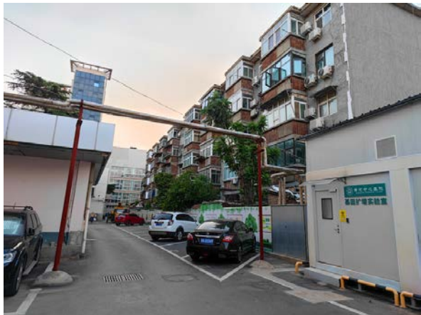
3 号病房楼北侧医院家属楼
